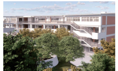
北屯區南興國小新建工程 （臺中市政府教育局提供）
